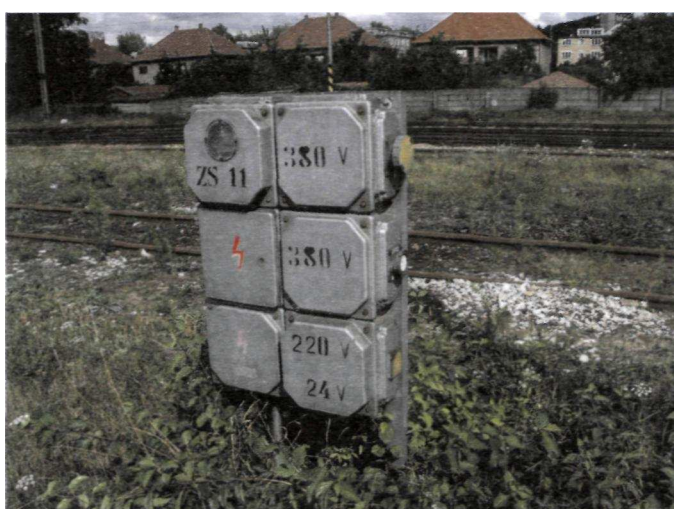
Obr. 15.9 Stavebnicová zostava rozvodníc
