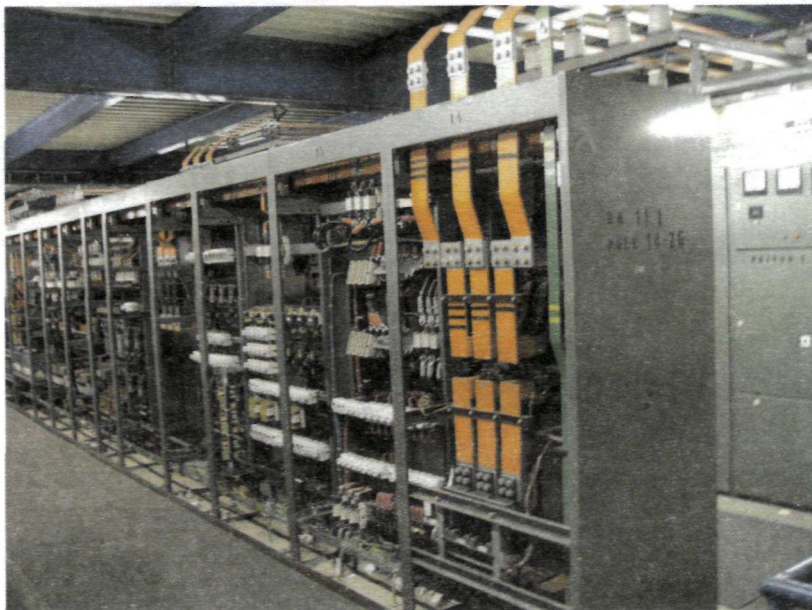
Obr. 15.2 Panelový rozvádzač
