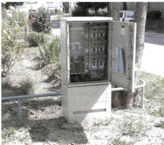
Obr. 15.11 Pozemná rozvodná káblová skriňa voľne stojaca
